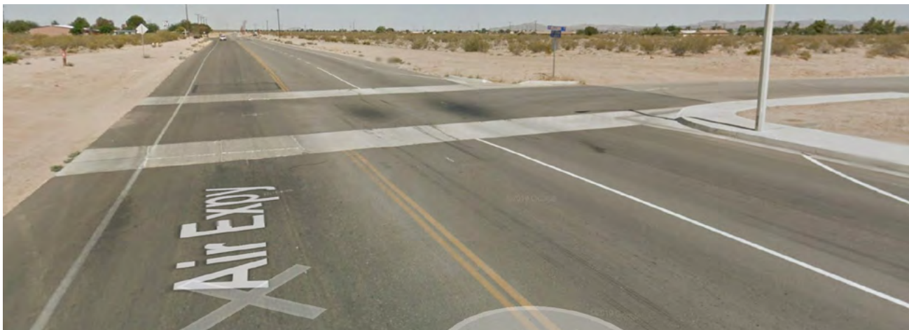
Los cruces peatonales sin señalizar y los arcones sin pavimentar en la intersección de la Autopista Air y la Calle Delicious crean un cruce inseguro para peatones y ciclistas.
