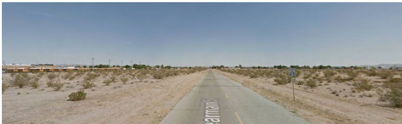
El ancho y la falta de espacio definido fomenta el exceso de velocidad, ya que conductores no esperan que peatones o ciclistas compartan la carretera en el Camino Pearmain, cerca de la Autopista Air, mirando al norte hacia la Avenida Bartlett.
