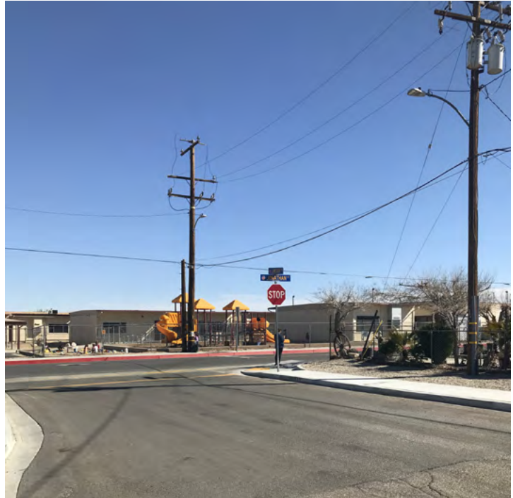
Dos farolas en frente de la Escuela Primaria Adelanto proporcionan toda la iluminación de las calles en la intersección de Calle Jonathan Street / Avenida Lawson.
