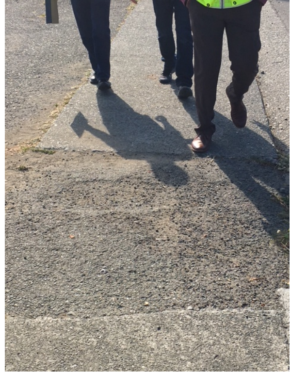
Banquetas con grava a lo largo de la Calle Giuntoli.
