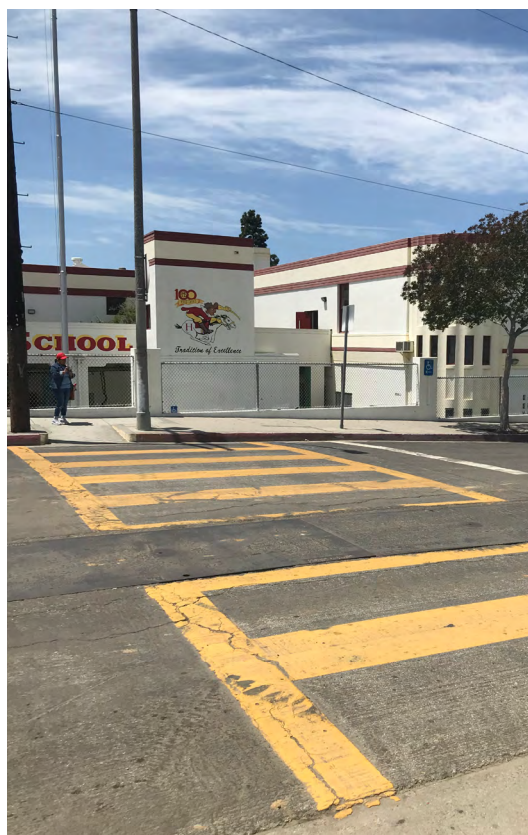
Cruce peatonal a medio bloque en la calle 6 en frente de la escuela secundaria Hollenbeck donde motoristas manejan a velocidades altas y hacen paradas 'rodando sin parar'. Credito de foto: California Walks
