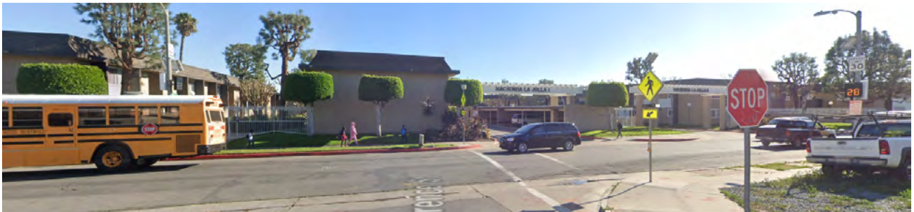
Sobre: El RRFB en la intersección de Calle La Jolla Oeste y Calle Lawrence mejora la visibilidad entre todos usuarios de la intersección. Abajo a la derecha: Iluminación orientada hacia la calle a lo largo del paseo elevado de Avenida Placentia Norte.
