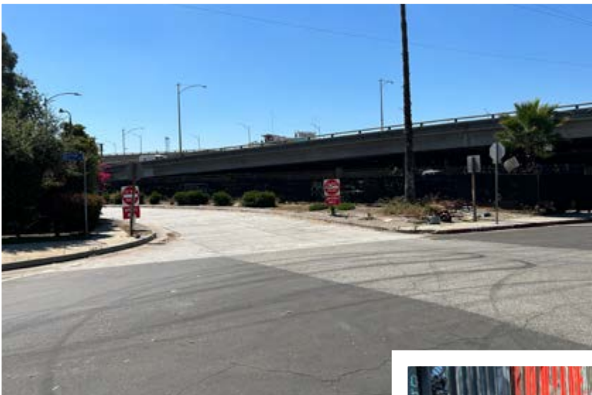
ARRIBA: La salida de la Interestatal 10, al lado del Parque Toberman en la intersección de la Calle Toberman y Calle 18, tiene múltiples marcas de llantas en la carretera.
