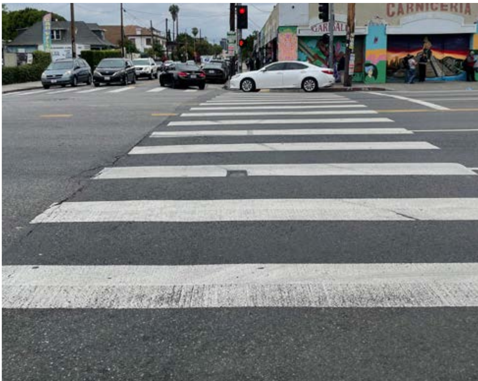
IZQUIERDA: Marcas de cruce peatonal continental en la intersección del Bulevar Washington Oeste y la Avenida Unión Sur.
