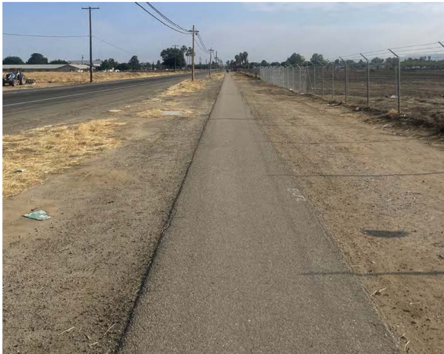
ARRIBA: Un camino de tierra en la SR-184 sin separación entre los peatones y los conductores.
