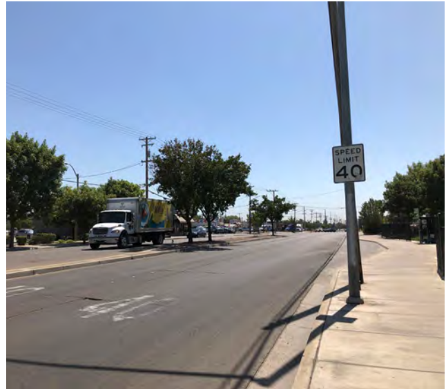
Derecha: Señalización descolorida de límite de velocidad en la Avenida Lander.
