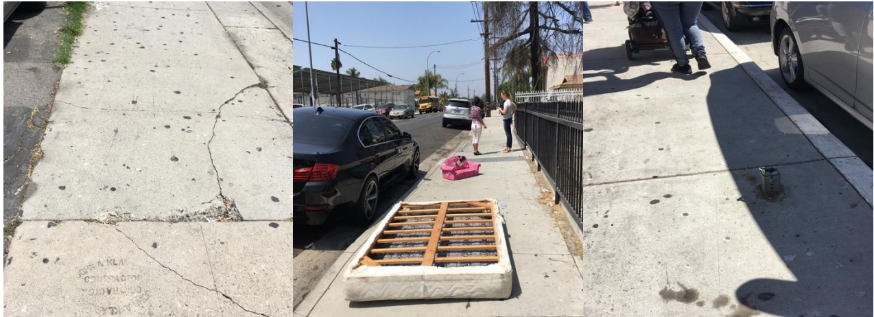
Banquetas en mal estado, vertederos y un poste de letrero afilado cerca del Parque Clara Street.
