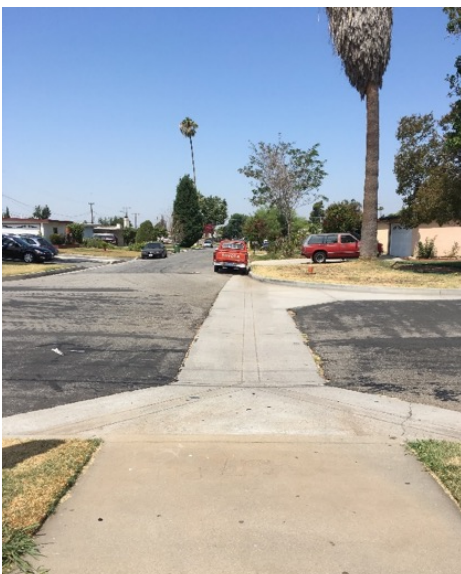
Un cruce no marcado con un canal de drenaje, en la zona de cruce, sobre la avenida Enid y calle Bygrove.
